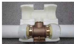
保温材に継手をセット
