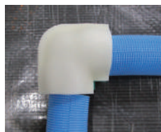
継手用保温材の取付
