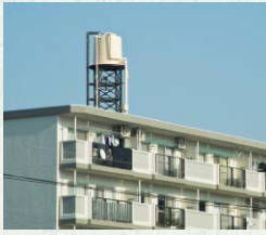
高架水槽式物件の高層階
