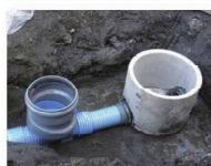
汚水ますとリブパイプの接合
