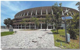
マンホールトイレ・高開放状態
