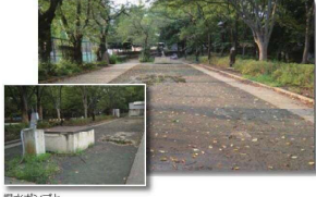
雨水ポンプと 洗浄ユニット排水槽
