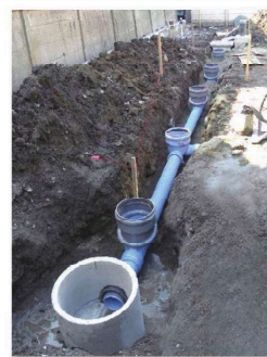
配管部分の完成
