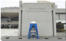
テント設置、マンホールトイレ・高開放状態
