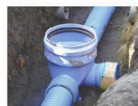
リブ付き小型マンホールは種類が豊富で、他の下水の合流も可能
