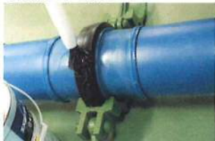
悪い例 (パイプ先端の噛み込み)
