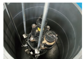
連結ボルト締め付け状況
