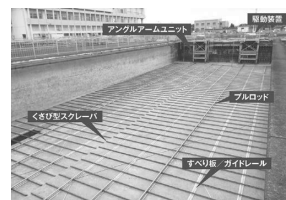
レスプロ式汚泥掻寄機 + 高濃度排泥装置
