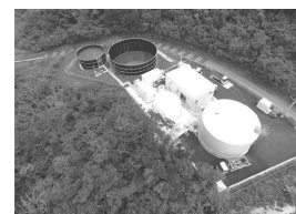
八重瀬町地域循環型 バイオガスプラント
