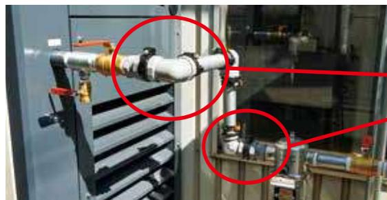
エアコンプレッサ配管の寸法調整で使用
