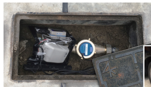
大阪市水道局様 実証実験 (鉄製蓋の上に駐車している状態での通信)
