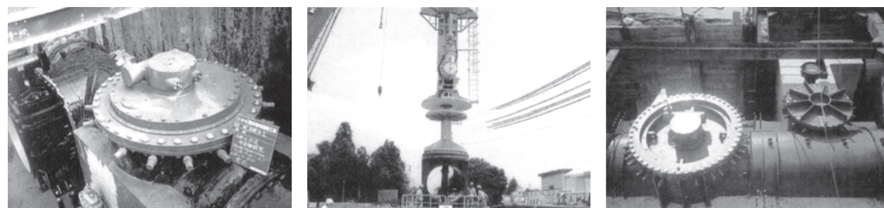
インサーパタフライ弁+割T字管M型弁体離脱式 インサーパタフライ弁 取付作業 インサーパタフライ弁+特殊分岐管Cカット(DC)
