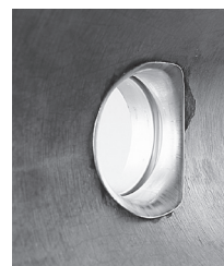
SUSブッシュ取付状況 (管内面)
