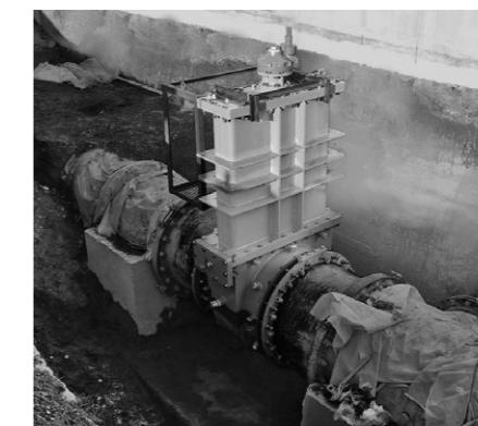
呼び径900設置状況
