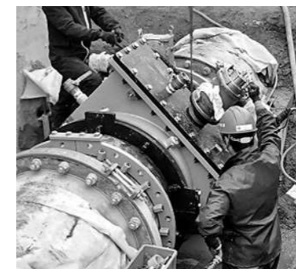
呼び径900穿孔作業状況
