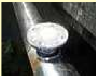
③ 凍結確認後、空気弁撤去
