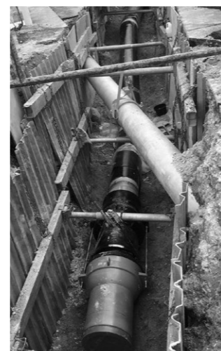
呼び径400設置状況
