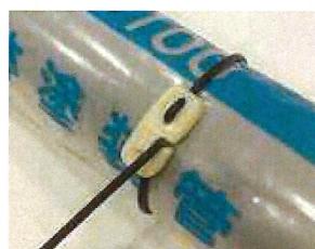
ゴムバンドを手前に引いて絞り、 固定部にゴムバンドを入れて固定。
