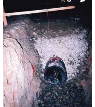
トンネル中央排水管工事
