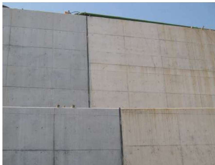
▲地下構造物の目地に使用
