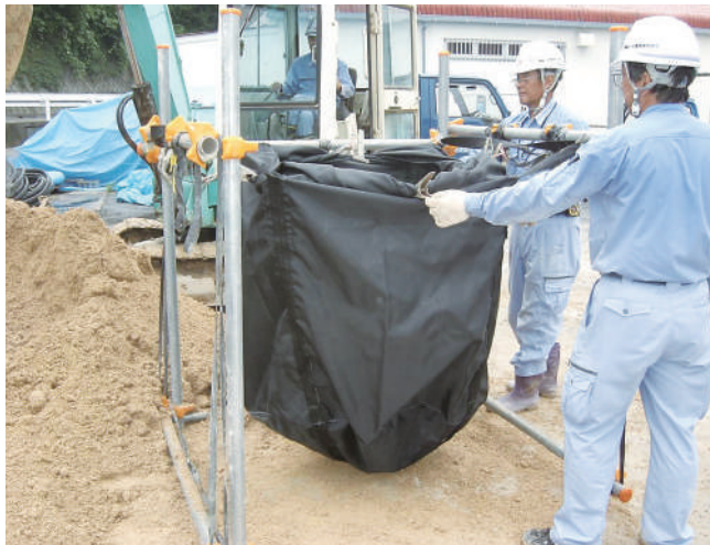
① TKバックを地面に対してやや宙ぶり気味にセットします。
