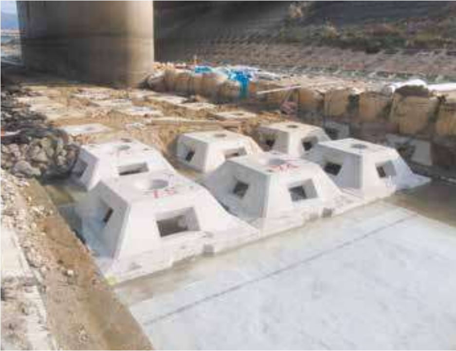
▲根固めブロックの固定にキュアマットINT-10を使用
