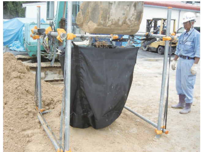
② TKバックの変形や損傷に注意しながら土砂を充填します。
