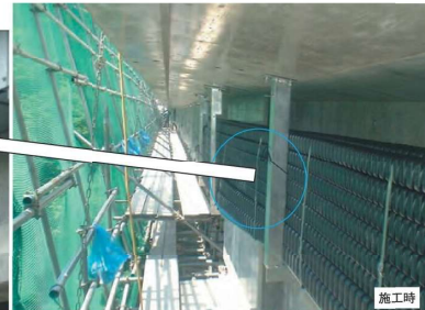
●橋梁添架 多条を軽量コンパクトに配管
