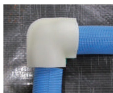
継手用保温材の取付
